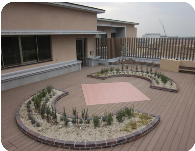
屋上テラス(3F)
